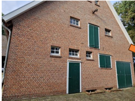
Frontansicht aus Richtung Auffahrt
